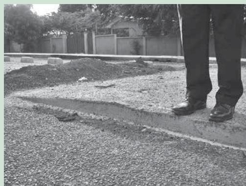
Ilustração da seção transversal de uma lombada de concreto, com 10 cm de altura e rampas de 1 m de comprimento para a velocidade desejada (30 km/h).
